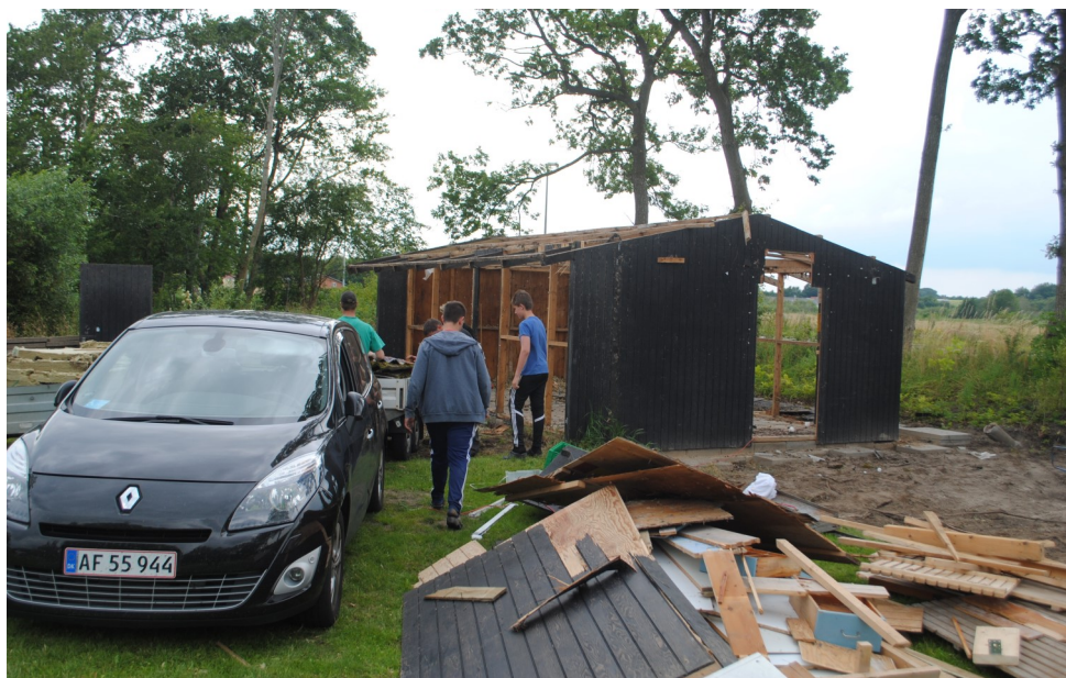
Familien Odgaard i gang med nedbrydning af den sidste del af bådehuset
